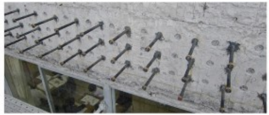
ブラストキー工法による施工事例
