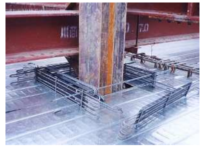
フラットデッキ (構台)
