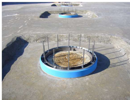
キャプリングパイル工法
